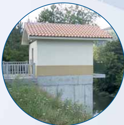
Mätstation, byggd enligt specifikation och komplett utrustad
