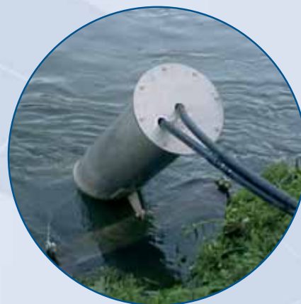
Pump i drift. Pumptyp väljs beroende på dess placering
